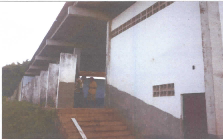
Foto 05 – Ginásio “O Joãozinho” Distrito de Tataíra
