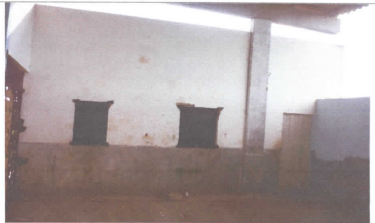
Foto 10 – Ginásio “O Joãozinho” Distrito de Tataíra
