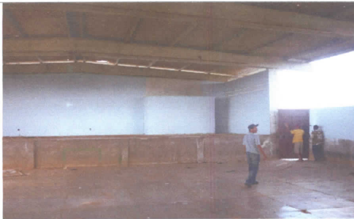
Foto 09 – Ginásio “O Joãozinho” Distrito de Tataíra
