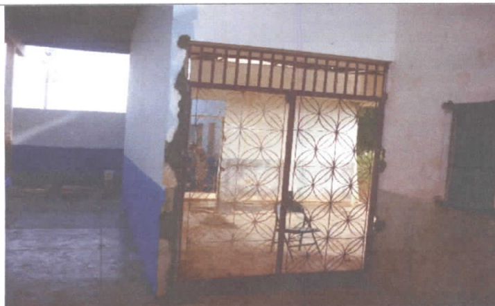
Foto 11 – Ginásio “O Joãozinho” Distrito de Tataíra
