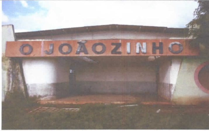
Foto 01 – Ginásio “O Joãozinho” Distrito de Tataíra
