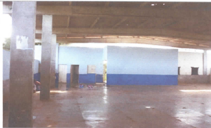
Foto 06 – Ginásio “O Joãozinho” Distrito de Tataíra
