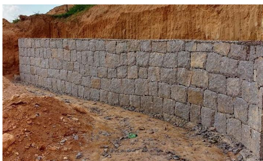
Figura 3: Muro em pedra rachão.
