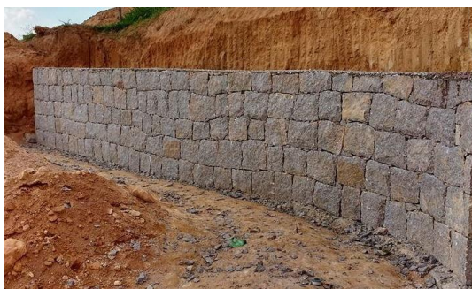
Figura 1: Muro em pedra rachão.
